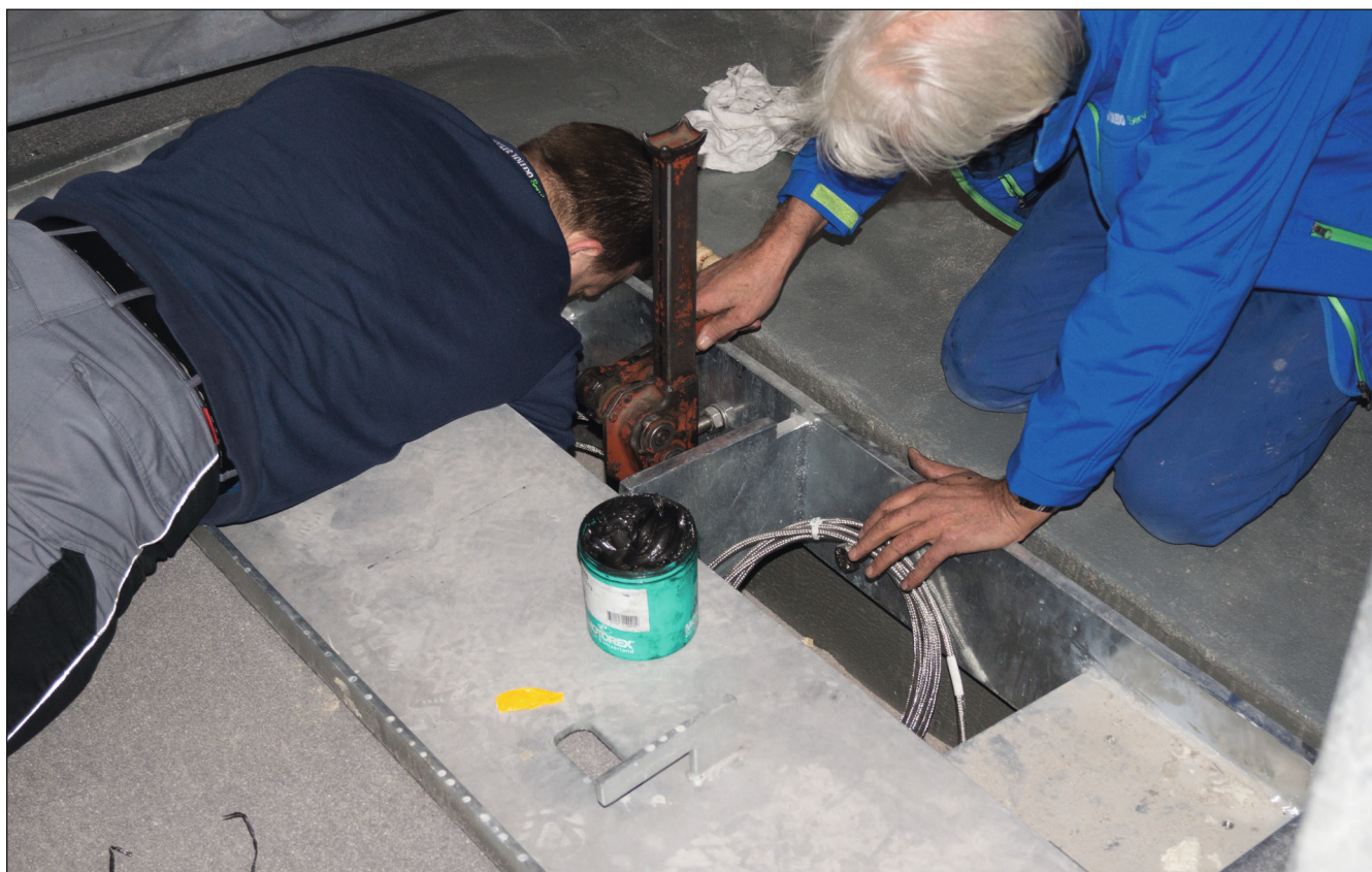
Serviceteknikere fra Mettler Toledo installerer vejecellerne.
