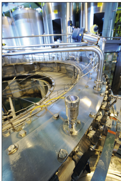
Det hygiejniske design og måleprincipet med guidede mikrobølger (TDR) sikrer den højest mulige målenøjagtighed i fødevarer-/drikkevarerindustrien og den farmaceutiske industri.
